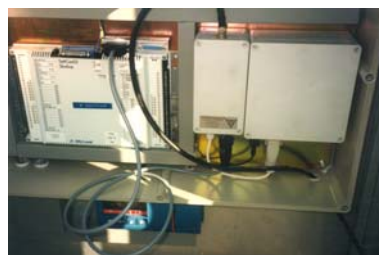
AlfaLaval PLC og radiomodem
