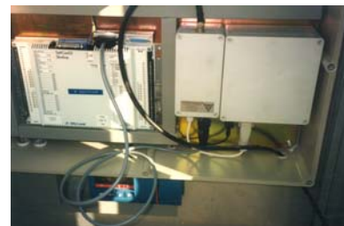
AlfaLaval PLC og radiomodem
